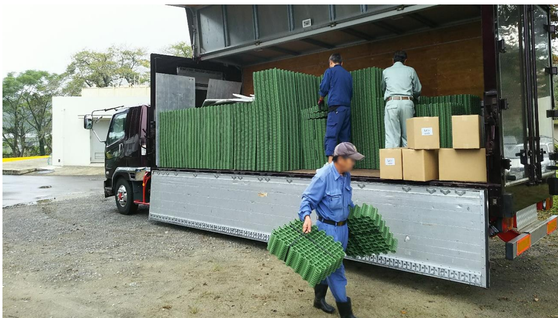
荷下ろし例 (バラ積み、車上渡し)
