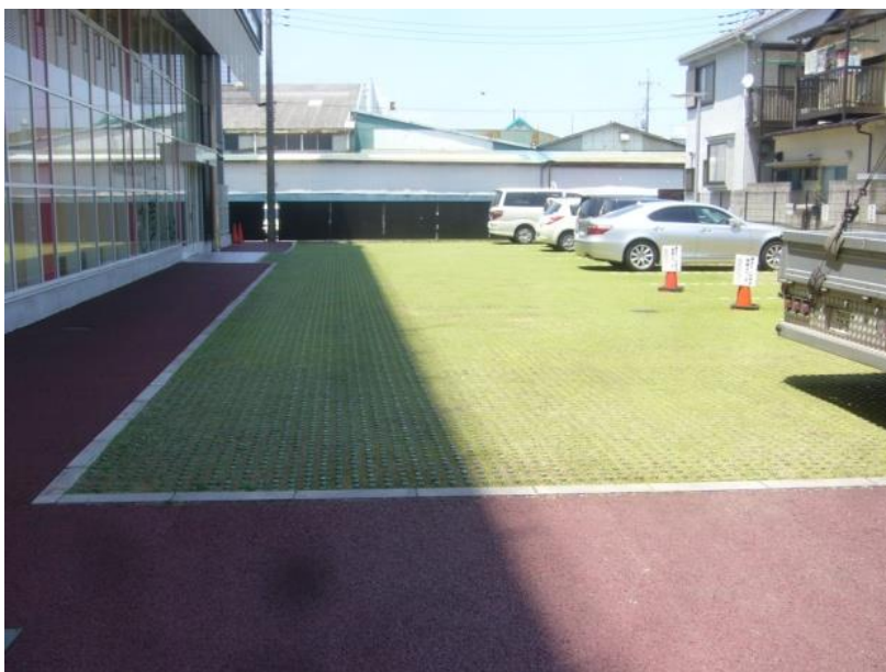
【写真 - 12 : 遊技施設駐車場（施工後4年経過）】
