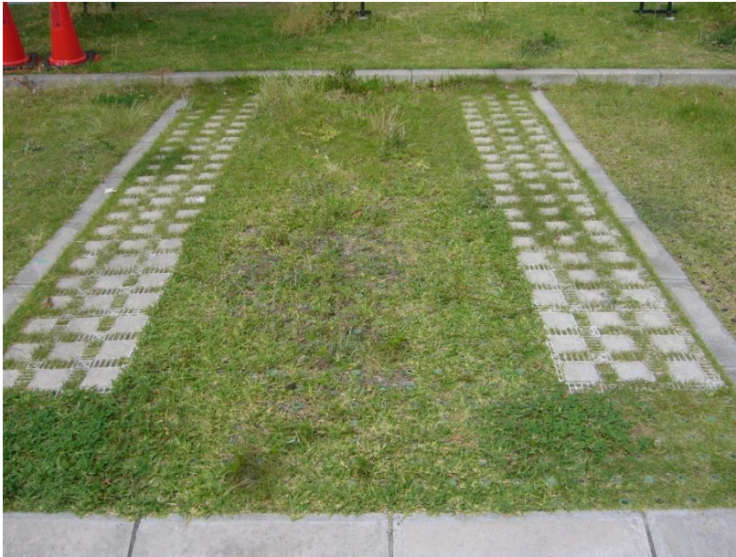
【写真 - 9 : 車両乗降部 (コンタイブロック+グリーンブロック)】
