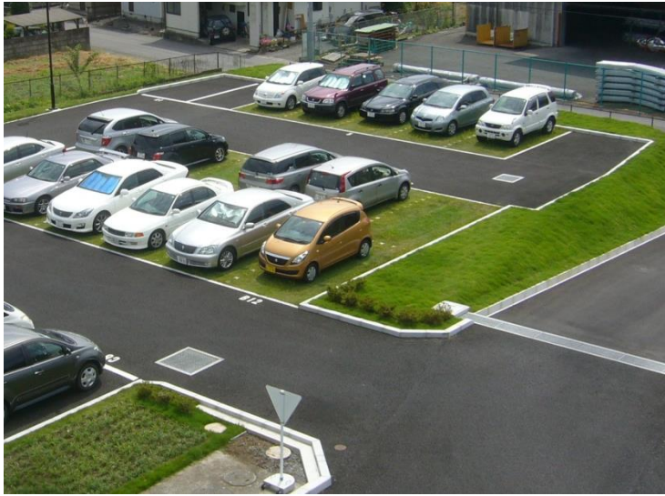
【写真 - 7 : ブロックテクター施工写真】
