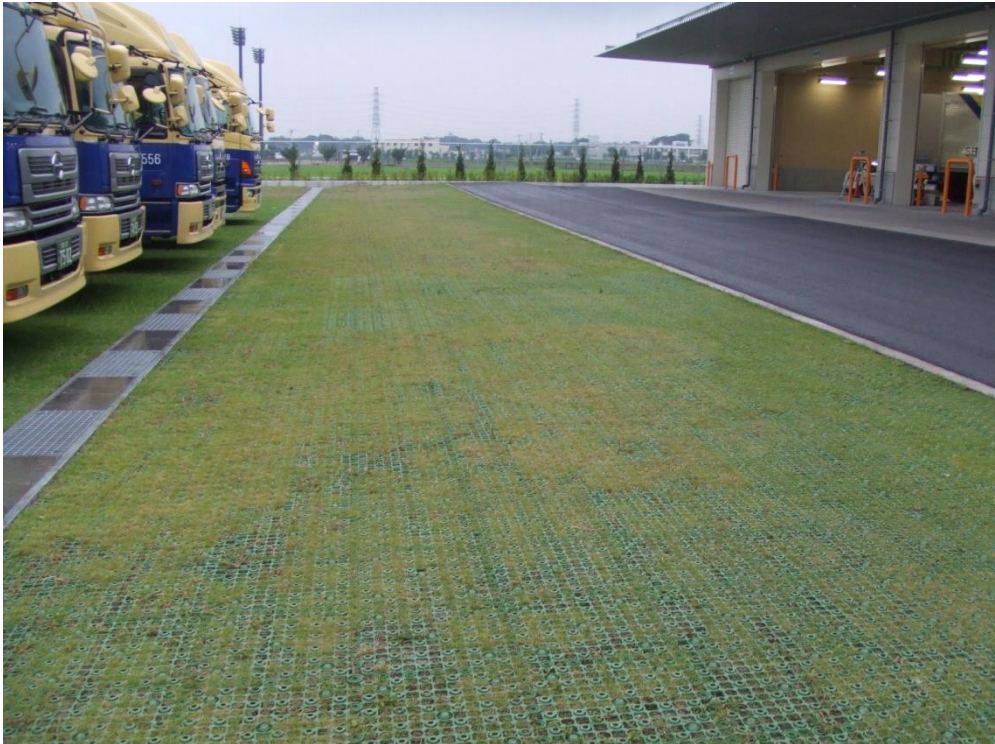
【写真 - 14 : ブロックテクター 倉庫の通路緑化（大型車乗入部）】
