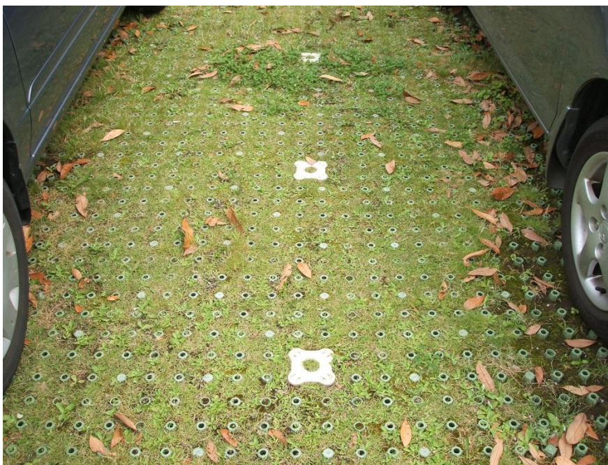
【写真-1：施工後 15 年経過、良好な状態（某清掃工場）】
