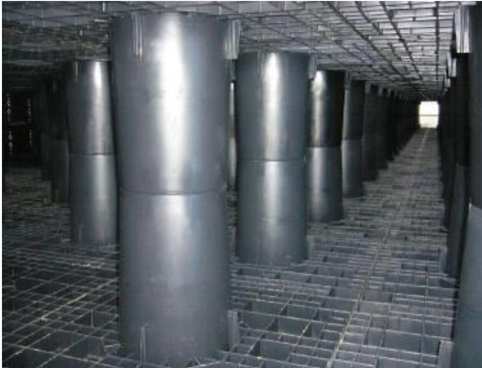
【写真 - 12 : シンシンプロック水槽内目視状況】
